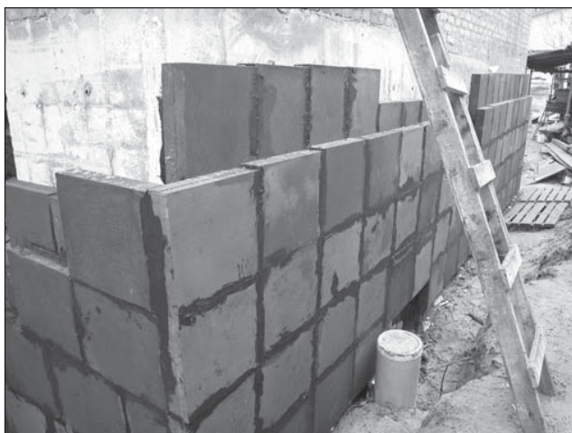
Утеплення стін першої української пасивної будівлі в Києві двома шарами спіненого скла. Архітектор Тетяна Ернст
