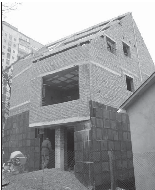
Зовнішнє утеплення масивних цегляних стін першої української пасивної будівлі в Києві стіненим склом. Архітектор Тетяна Ернст
