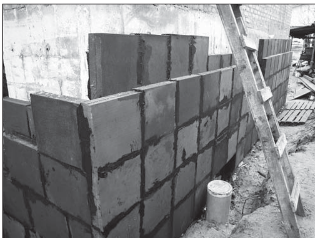
Утеплення цегляних стін першого пасивного будинку в Києві (арх.Т.Ернст) спіненим склом
