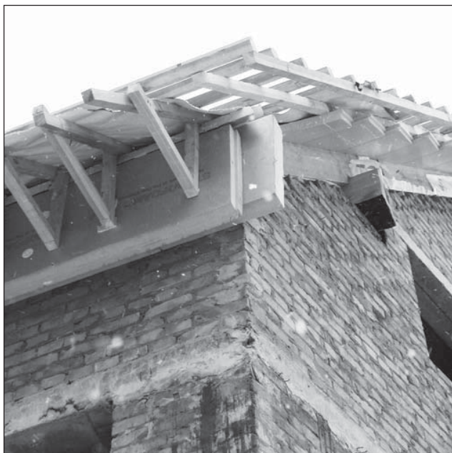
Утеплення даху першого пасивного будинку в Києві (арх.Т.Ернст) екструдованим пінополістиролом (між стропилами і по стропилах)
