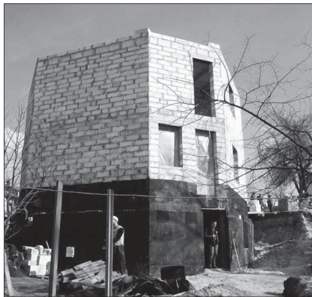
Утеплення стін з газоблоку пасивного будинку в Чернігові (арх.Т.Ернст) спіненим склом
