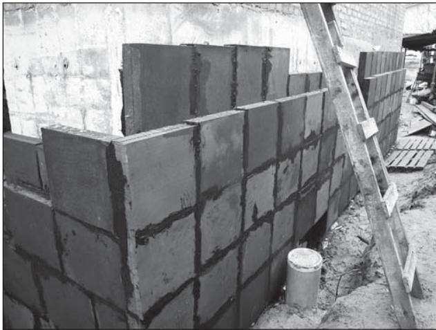
Утеплення цегляних стін першого пасивного будинку в Києві (арх.Т.Ернст) спіненим скло
