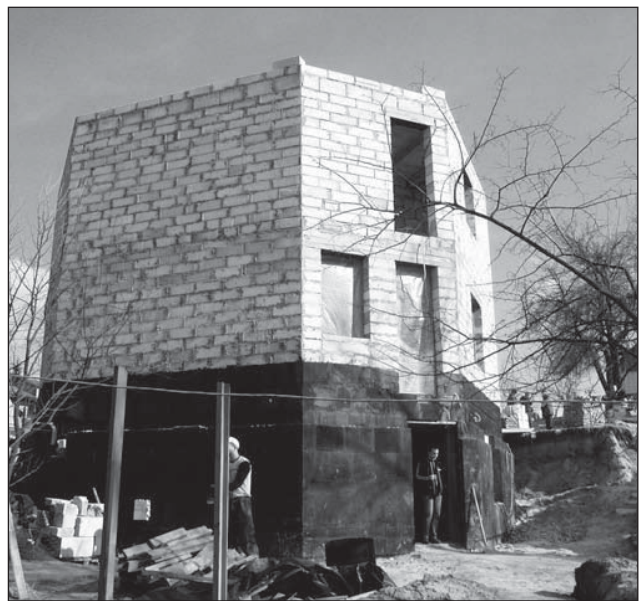
Утеплення стін з газоблоку пасивного будинку в Чернівці (арх.Т.Ернст) спіненим скло
