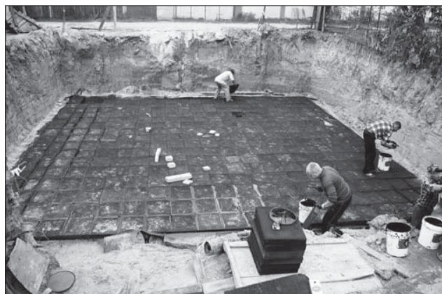
Утеплення першого пасивного будинку в Києві (арх.Т.Ернст) спіненим склом під фундаментною подушкою
