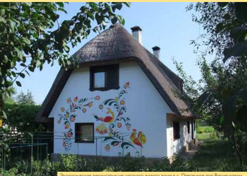
Экологическая реконструкция частного жилого дома в с. Плесецкое под Васильковом
