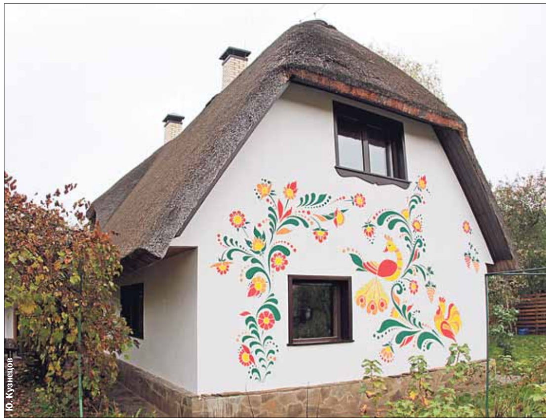
Камыш. Использовали не только для изготовления крыши, но и для утепления стен экоддома
